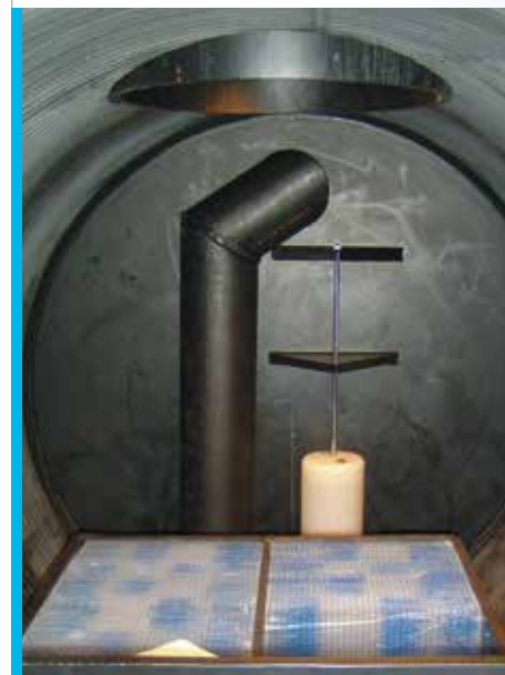
Binnenzicht afscheider: coalescentiecel + automatische afsluiter
